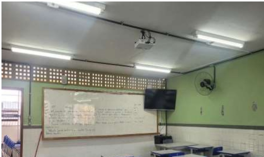
Imagem 4 - Sala com nova instalação elétrica, pintura e os equipamentos tecnológicos instalados
