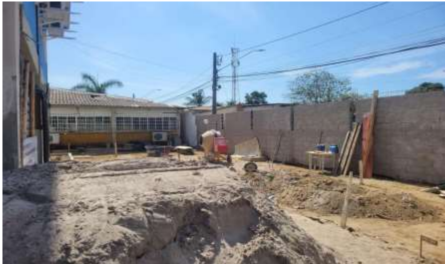
Imagem 3 - Pátio e muro em obras
