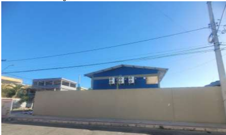
Imagem 2 - Foto atual da lateral da escola
