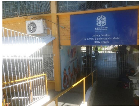
Imagem 2 – Acessos ao portão principal
